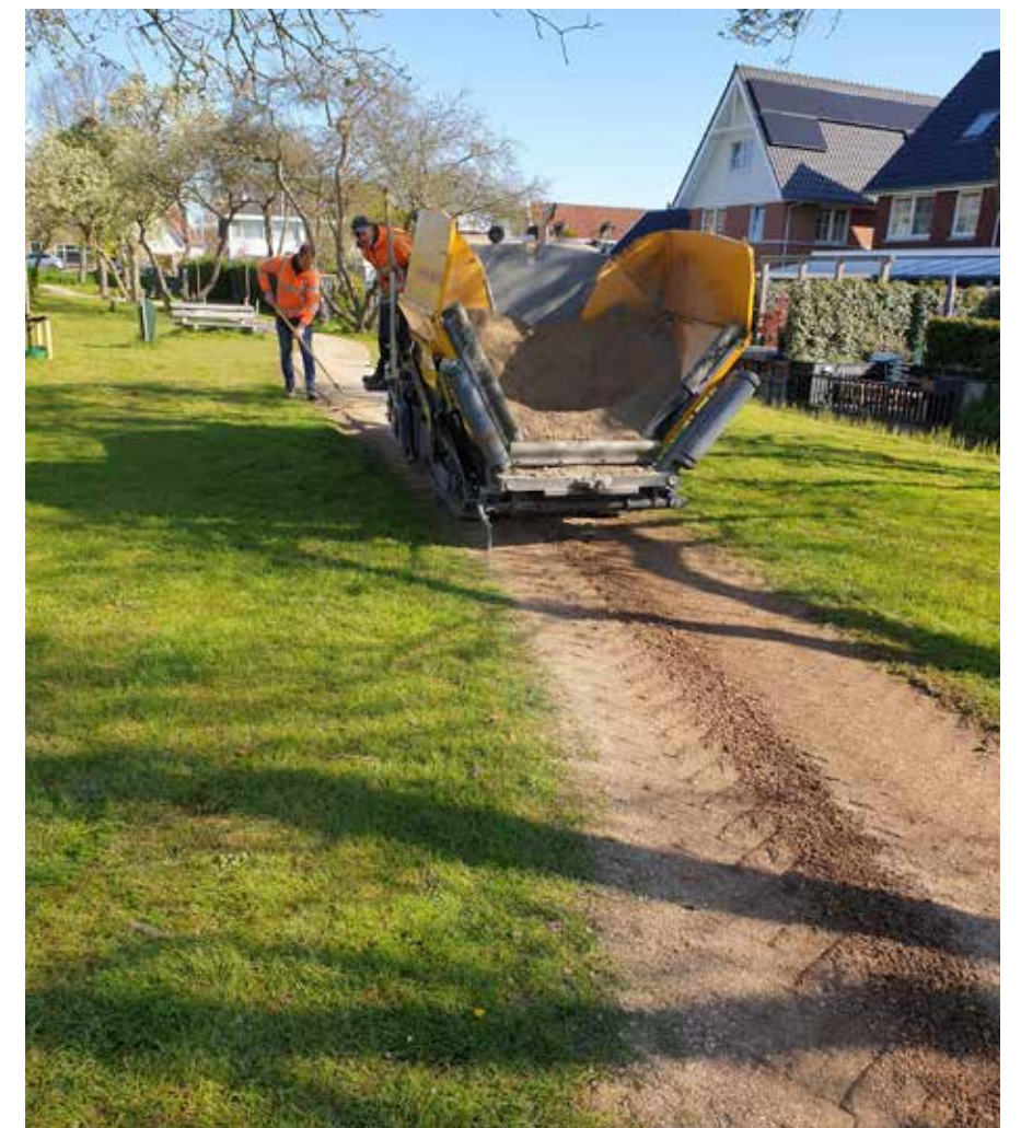
De aanleg van een pad met HanseGrand halfverharding in de gemeente Nissewaard.
