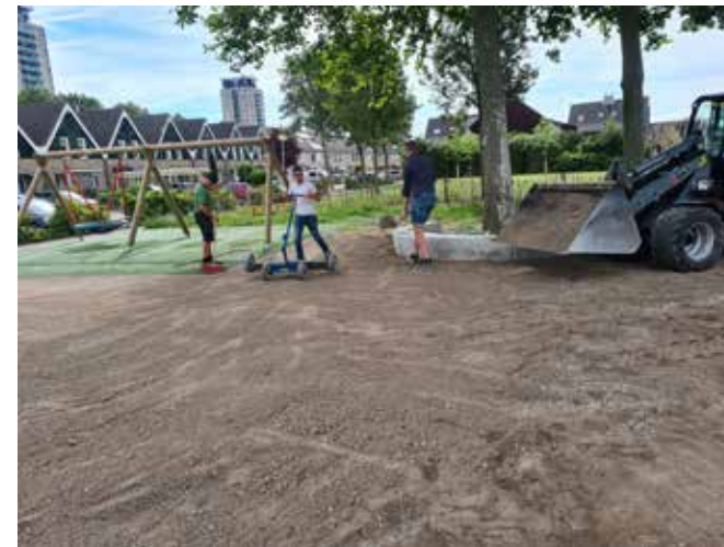
De aanleg van een speeltuin.
