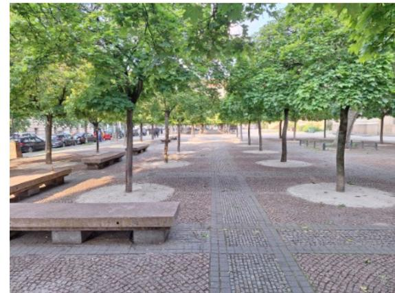
Die leicht kegelförmig modellierten Flächen sorgen dafür, dass das Regenwasser gezielt zu den Wurzeln abfließen kann. Die Beläge sind luft- und extrem wasserdurchlässig. Sie bleiben dauerhaft dynamisch und elastisch. So können die Bäume ungestört wachsen und sich im Wurzelraum ausdehnen.
