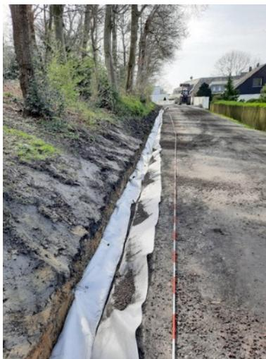
Die Höhe der Auffüllung betrug im Durchschnitt ca. 50 cm. Anschließend wurde über den Blähton Schotter der Größe 32/56 mm eingebaut.
