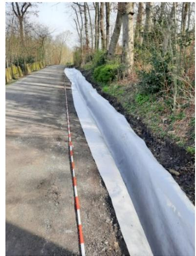
Es wurde ein etwa 70 cm tiefer Graben entlang des Hangs ausgehoben und mit einem Geotextilvlies ausgekleidet.
